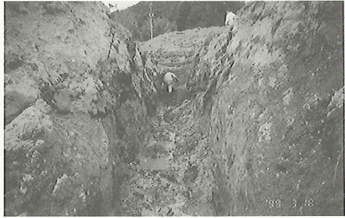
写真4.1.2-6 H地区トレンチ調査
