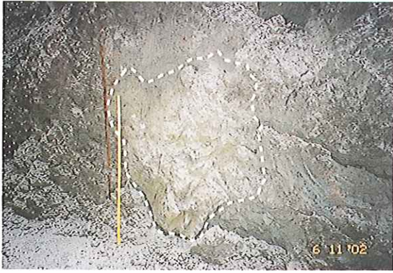
写真4.3-1 シルトブロック 碎屑岩脈である可能性もある。物差しの長さは1m
