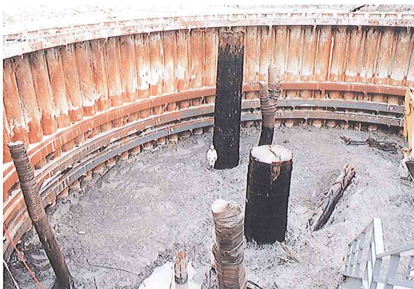
縄文の森発掘保存展示棟 整備工事 （約 5 m掘り下げた状況） ▶
