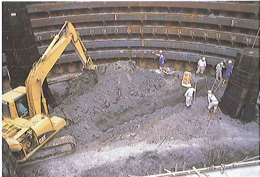
河川跡確認のための トレンチ調査 ▶
